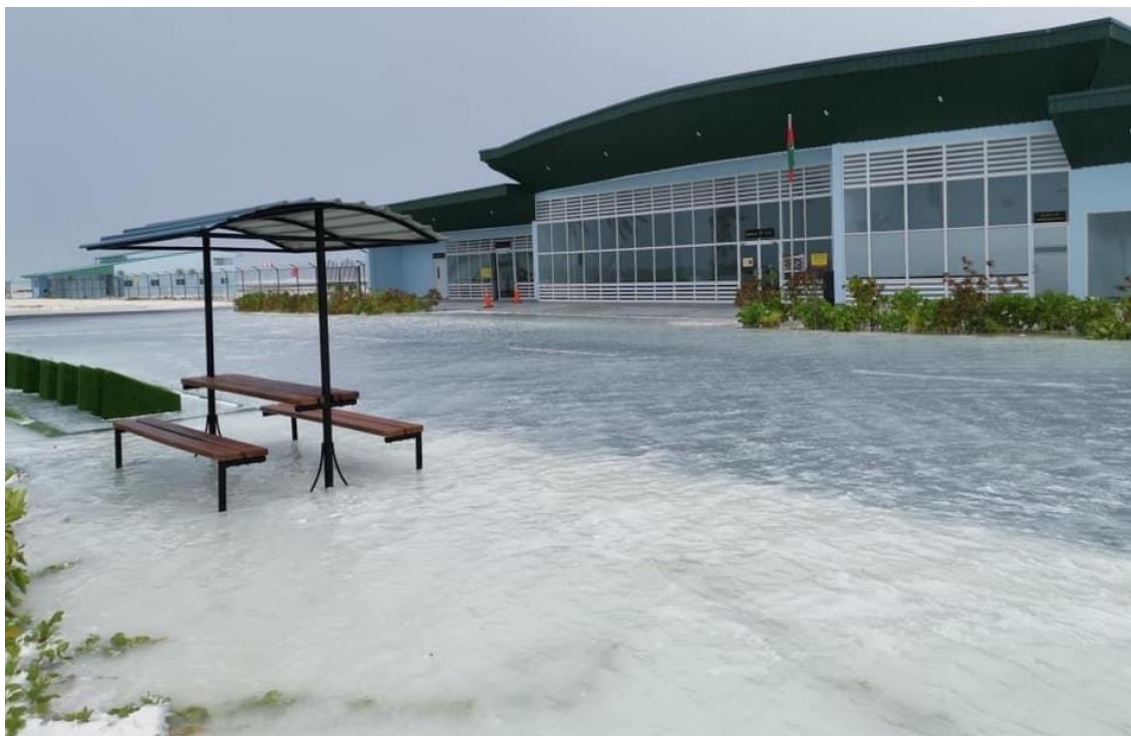
Primeras inundaciones con daños severos del Aeropuerto de Hoarafushi, Maldivas, en mayo de 2021
